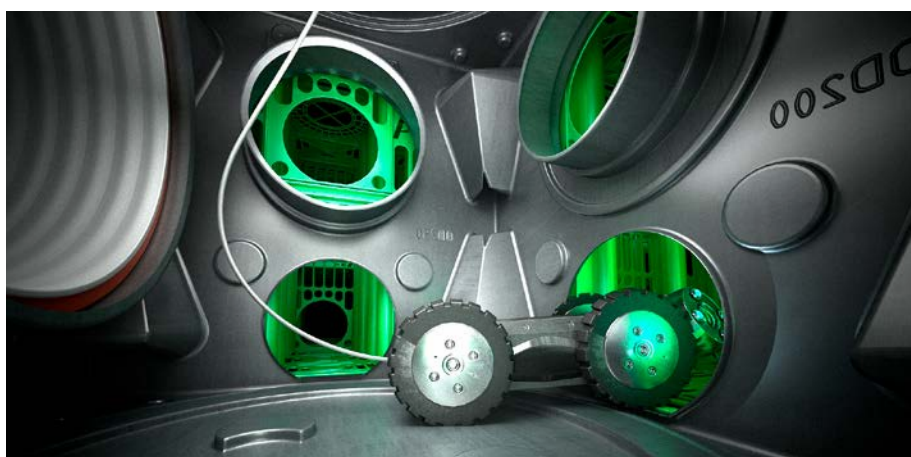
Inspekcja zbiornika poprzez studzienkę kontrolną 600 mm
