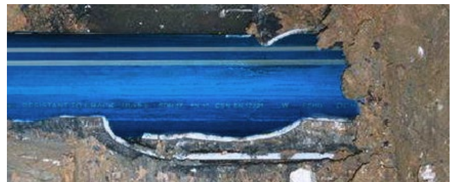
Rura ROBUST układana metodą burstingu
