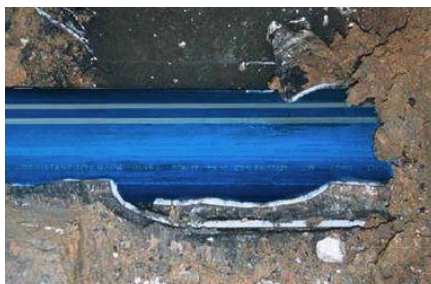
Rura ROBUST układana metodą burstingu
