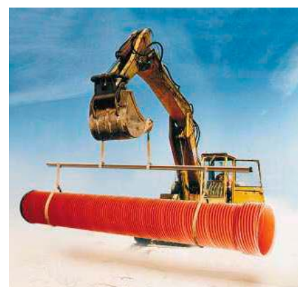
Transport rury za pomocą zawiesia
